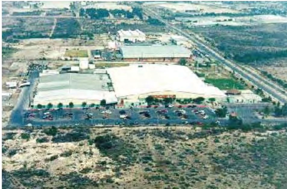
Aparatos Eléctricos de Acuña, S.A. de C.V.
