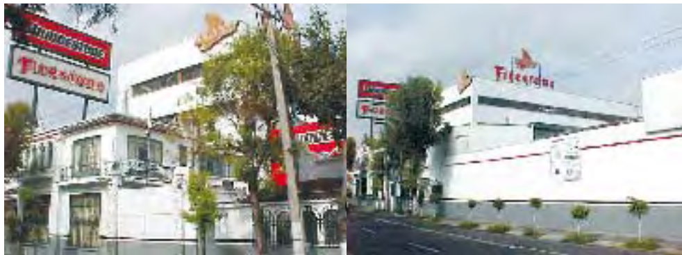
Bridgestone Firestone de México, S.A. de C.V., Planta México.
